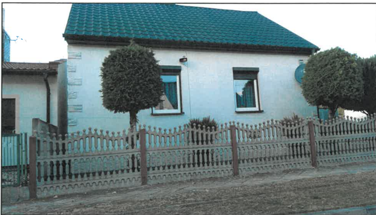
Drewniany budynek - ul. Zachodnia 6.
